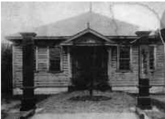
大正5年建築の役場庁舎
