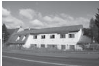
解体・整理することになった旧塩狩温泉
