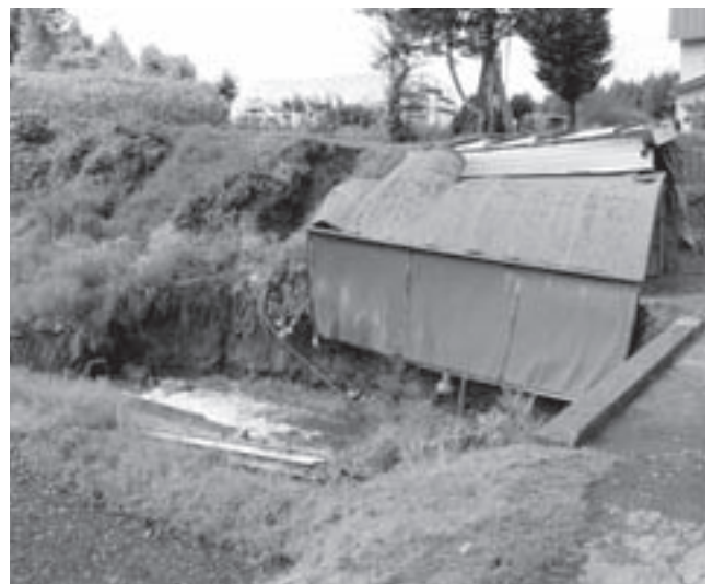
大成川の護岸崩落
