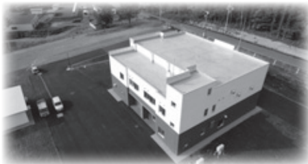
東丘浄水場建設事業
