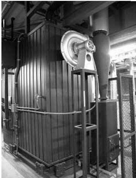
子供センターのペレットボイラー
