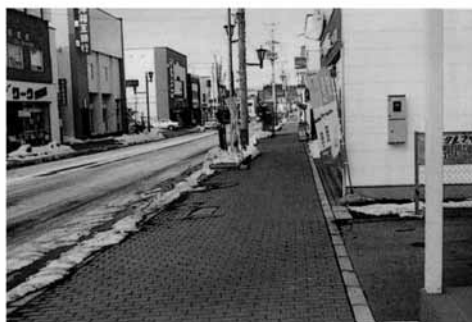
ロードヒーティング熱水利用(北海道弟子屈町)
