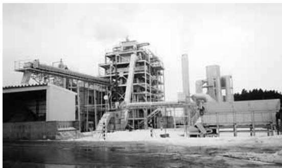
隣接する製材所からの端材を利用して発電し、工場の電気に利用(秋田県能代市) (資料)能代森林資源利用協同組合
