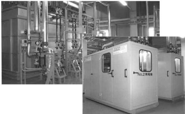
生ごみを発酵処理して発電する北空知衛生センター 「生ごみバイオガス化施設」(北海道深川市) (資料)北空知衛生センターパンフレット
