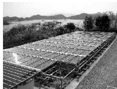
太陽熱利用システム: 集めた熱は温水プールに利用 (資料) 姫路市
