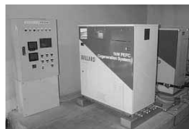
家庭用燃料電池 1kW 級の実験機 (北海道大学構内)
