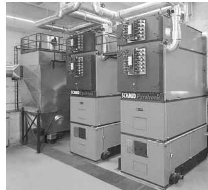
チップボイラー (資料)株トモエテクノパンフレット
