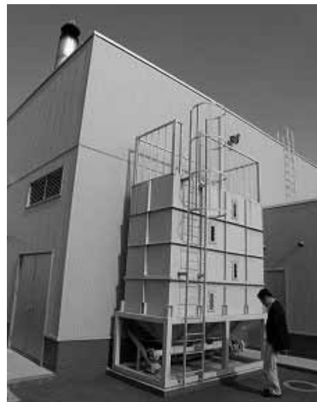
子供センターのペレットタンク
