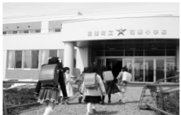
和寒小学校校舎改築
