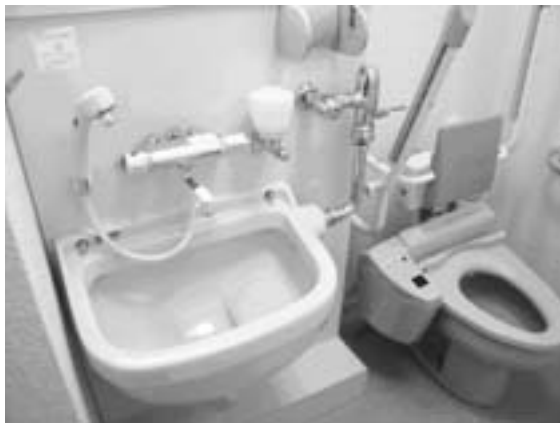
町民センターに設置した オストメイト対応型トイレ
