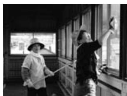
跨線橋の清掃作業
