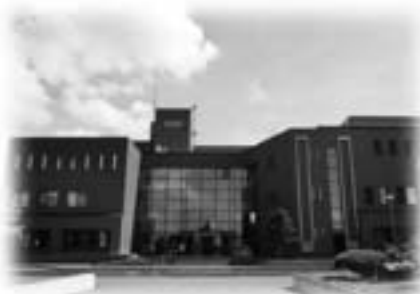
総合庁舎耐震改修事業
