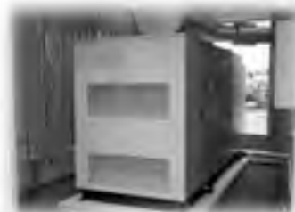
総合庁舎非常用発電設備整備事業
