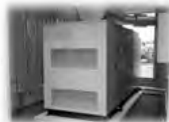
総合庁舎非常用発電設備整備事業
