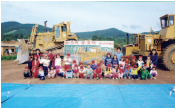
保育所児童 高速和寒インター工事見学 (平成9年9月)
