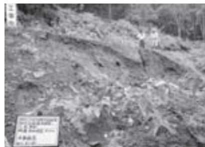
林道西和東線 法面崩落
