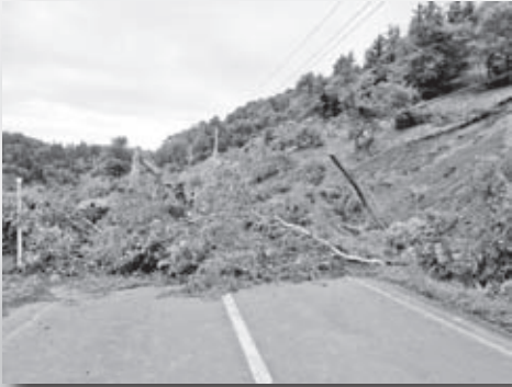
福原で起きた土砂崩れ
