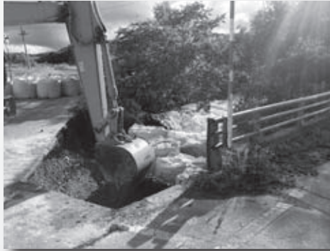
西和11線川の仮復旧作業
