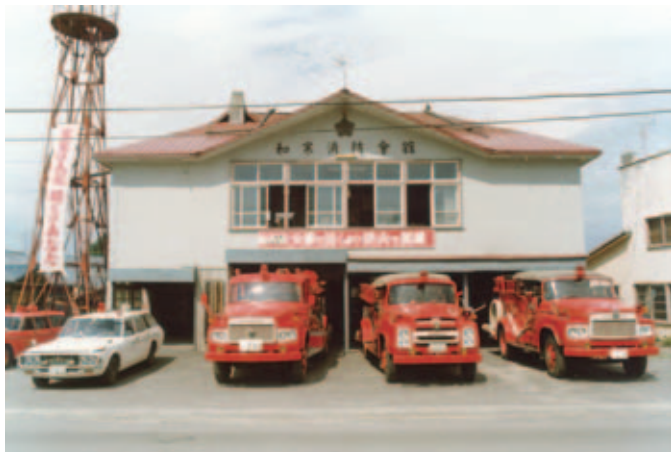
消防庁舎（昭和52年）
