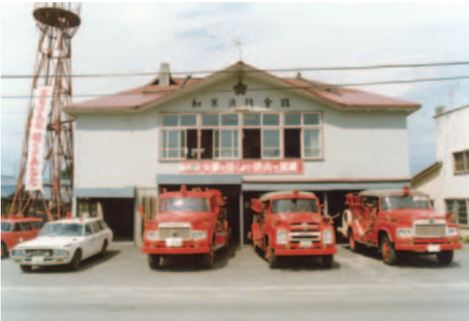
消防庁舎（昭和52年）
