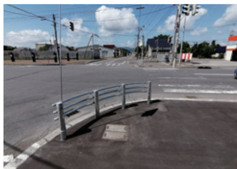
ガードレール（16線交差点）
