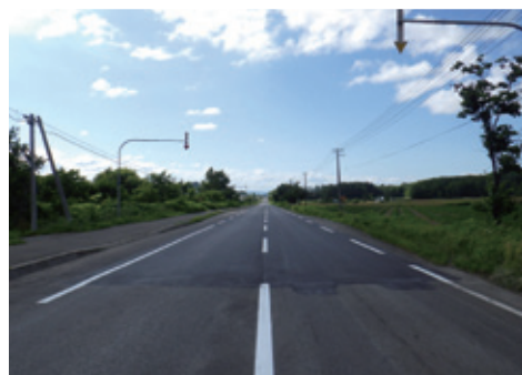
国道40号線（朝日地区）
