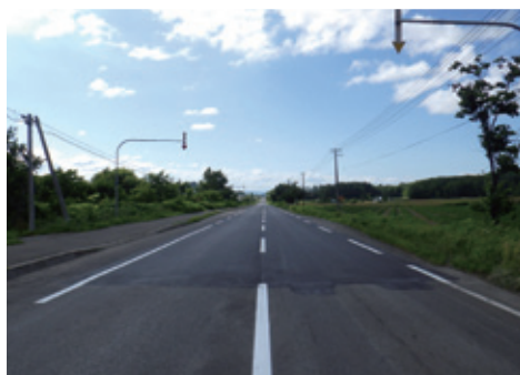
国道40号線（朝日地区）
