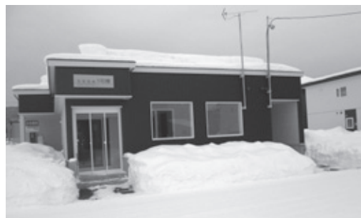
道路に面した廊下の出入口
