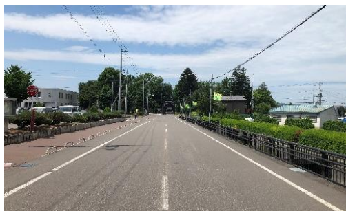
バリアフリー化を進めた町道
