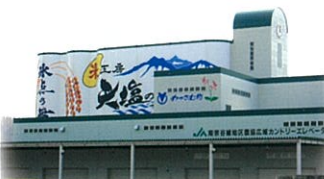
南宗谷線地区広域米穀乾燥調整貯蔵施設 米工房「天塩の大地」
