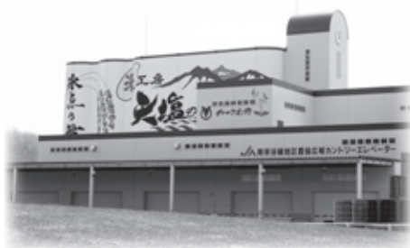
カントリーエレベーター改修事業
