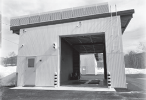
リサイクルセンターストックヤード 新築工事 (写真：計量棟)
