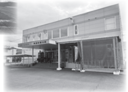
産業会館改修工事
