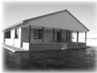
若草集会所新築工事
