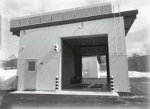
リサイクルセンタースtockヤード 新築工事（写真：計量棟）
