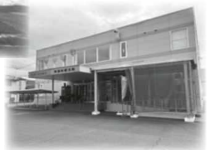
産業会館改修工事
