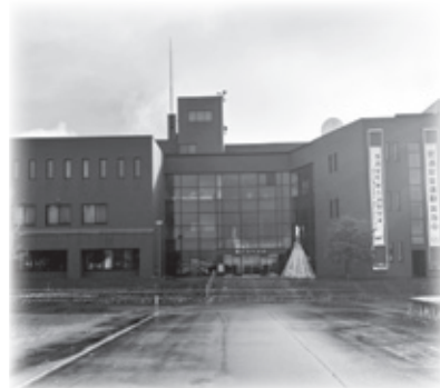
公共施設照明LED化 (総合庁舎・公民館・小中学校・総合体育館)
