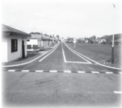
公営住宅団地内道路整備
