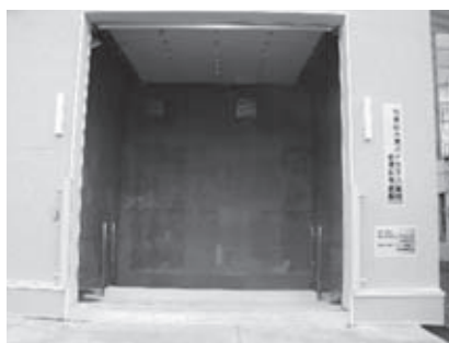
▲総合庁舎横で稼働中の木質バイオマス熱源供給施設
