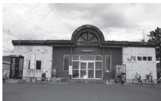
▲水洗トイレの要望が出ているJR和寒駅
