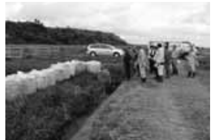
▲被害箇所の調査
