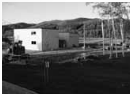
▲イベント広場工事状況
