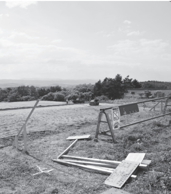
▲東丘浄水場建設工事風景
