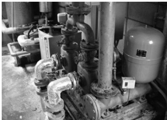
▲保養センターボイラー室
