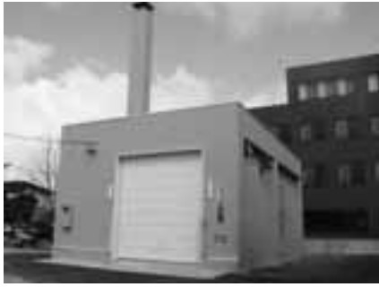
▲熱源供給施設
