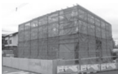
▲町内施工業者の利用が望まれる
