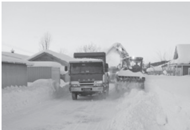
▲町道排雪作業の様子
