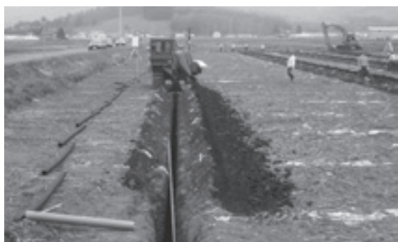
▲基盤整備事業（暗渠）
