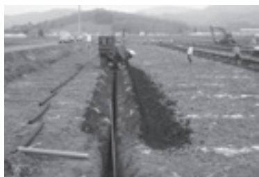
▲暗渠排水の工事
