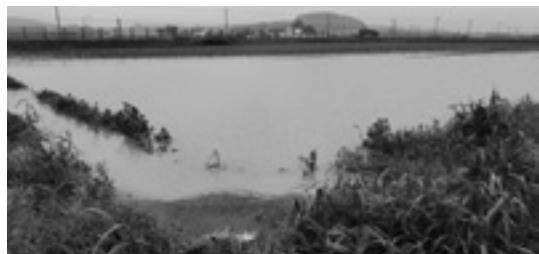
▲8月の大雨による冠水状況
