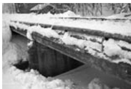
▲50年以上経過した橋(東和三号橋)
