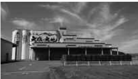
▲カントリーエレベーター
