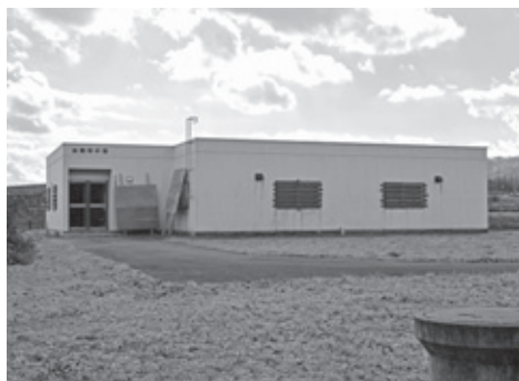
▲北原・菊野地区（三和）浄水場
