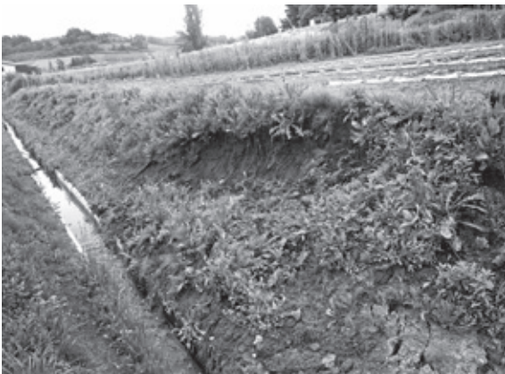
▲大雨災害により法面崩壊を受けた圃場
