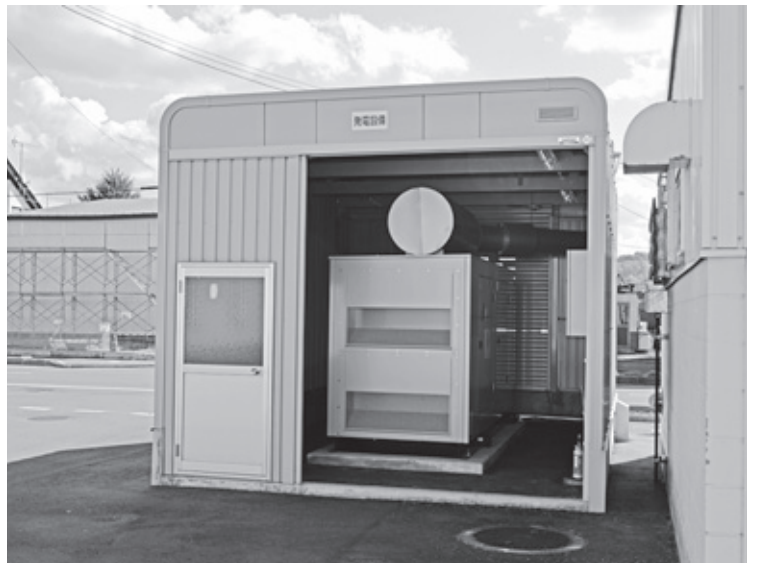
▲停電時に稼働した役場非常用電源設備
