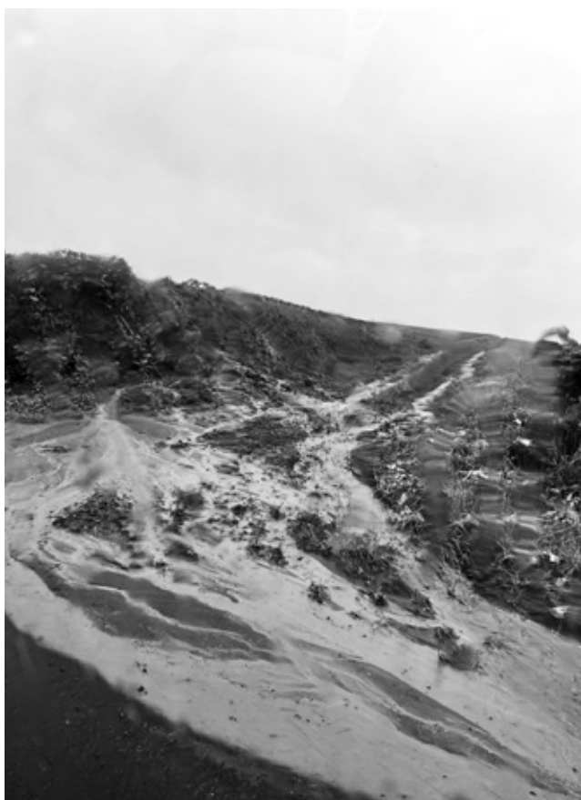
▲大雨で畑から土壌流失した菊野地区の農道
