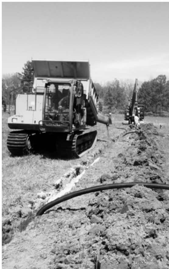
▲畑の水はけを良くするための暗渠排水工事
