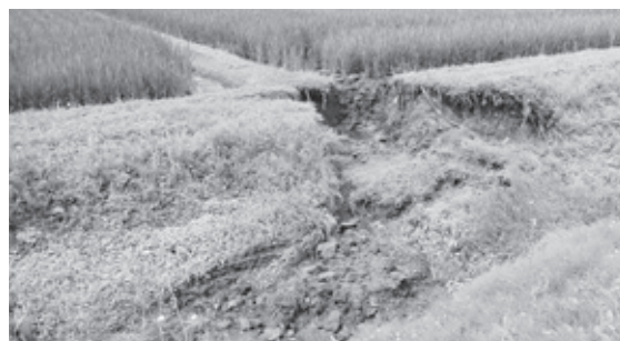
▲大雨で畦が崩壊した田んぼ
