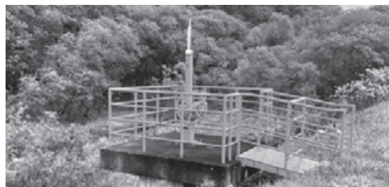
▲大雨時には適切な操作が重要となる樋門
