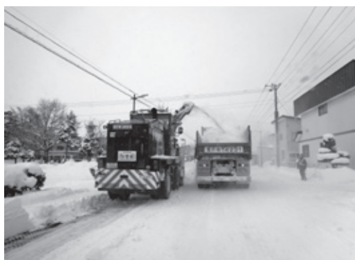
▲道幅を広く丁寧に除排雪作業の様子
