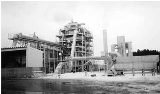
隣接する製材所からの端材を利用して発電し、工場の電気に利用(秋田県能代市)
