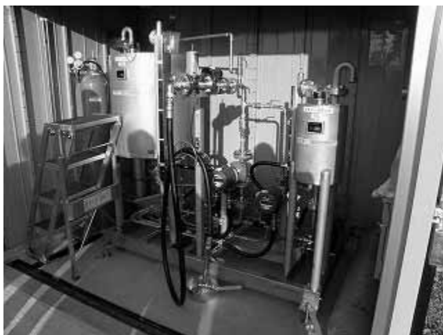
バイオエタノール製造設備
