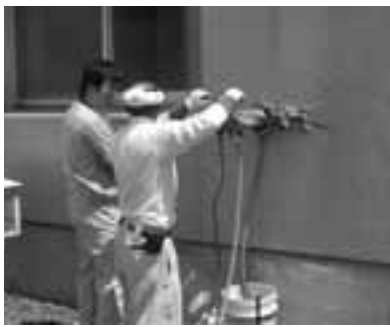
▲病院耐震調査
