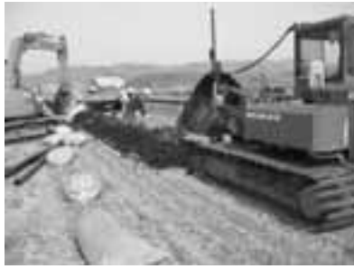
▲土地基盤整備現場
