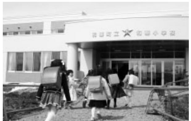
和寒小学校校舎改築
