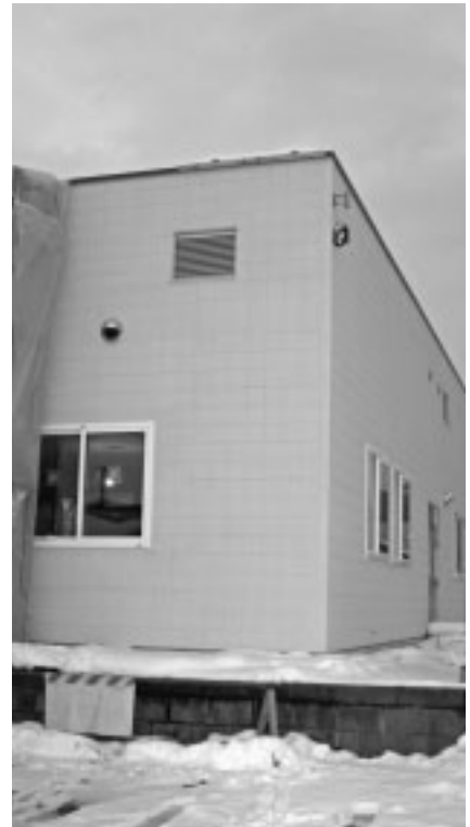
子育て支援センター（仮称）着工
