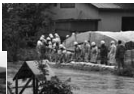
三笠地区 河川が増水し、住 宅への浸水を防ぐため土のう を積む消防団
