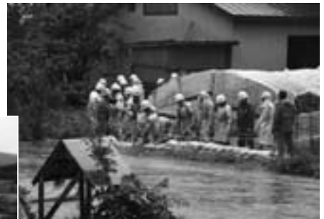
三笠地区 河川が増水し、住 宅への浸水を防ぐため土のう を積む消防団
