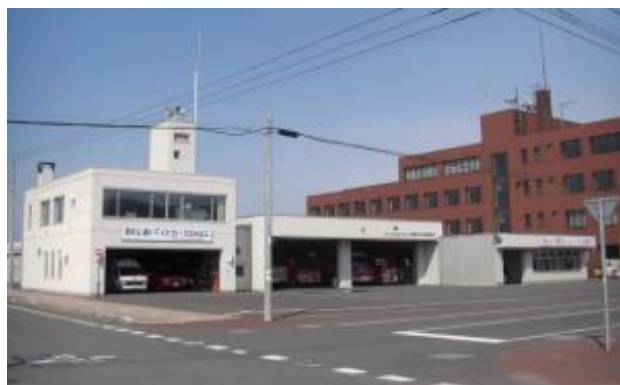
左：消防署（白い建物）右：庁舎
