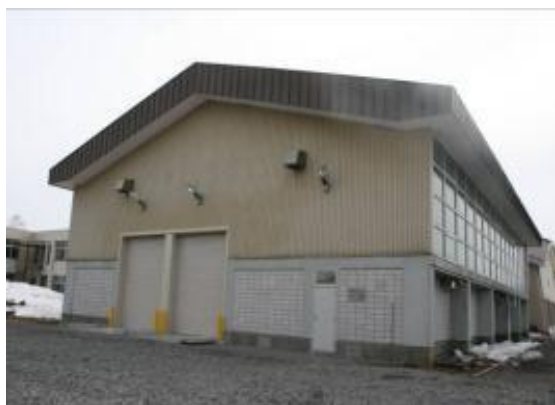
木質バイオマス燃料製造施設
