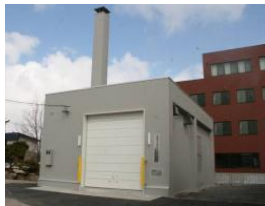
木質バイオマス熱源供給施設
