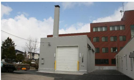
地球温暖化対策や化石燃料に代わる燃料として木質バイオマス燃料製造施設で製造した木質チップを燃焼して役場庁舎、保健福祉センター、図書館に熱源(暖房)を供給する施設です。
